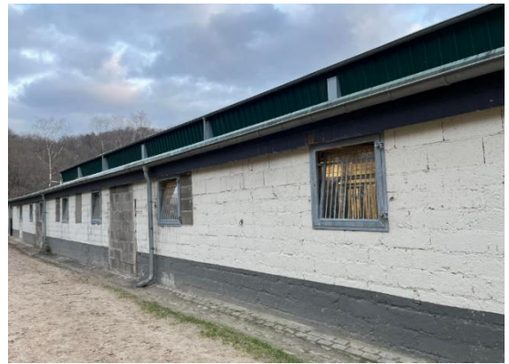
Einbau von Fenstern in den neuen Boxen in der Stallgasse (Wurmseite)
