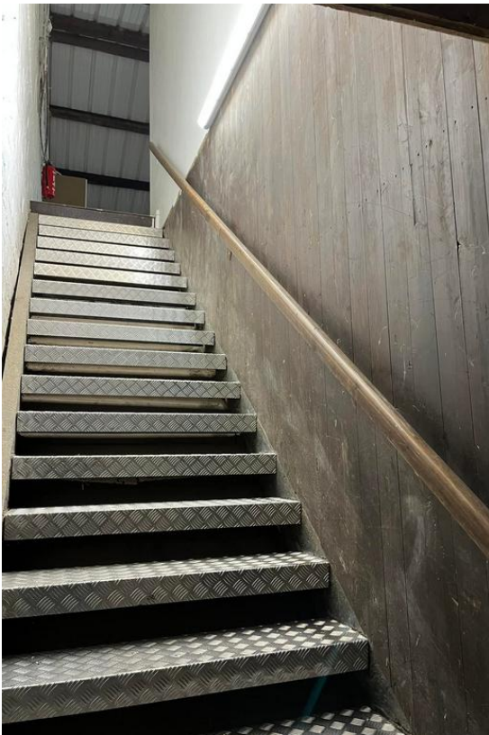
Neue rutschfeste Auftritte
